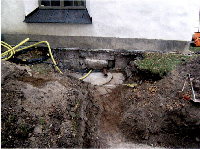
Fig. 4. Det medeltida golvet i Alunda kyrkas norra vapenhus som framkom i schakt för nya VA-ledningar. Observera ristningen i fasaden höger om fönstret som markerar nordportalen. Foto Anna Ölund, Upplandsmuseet.
