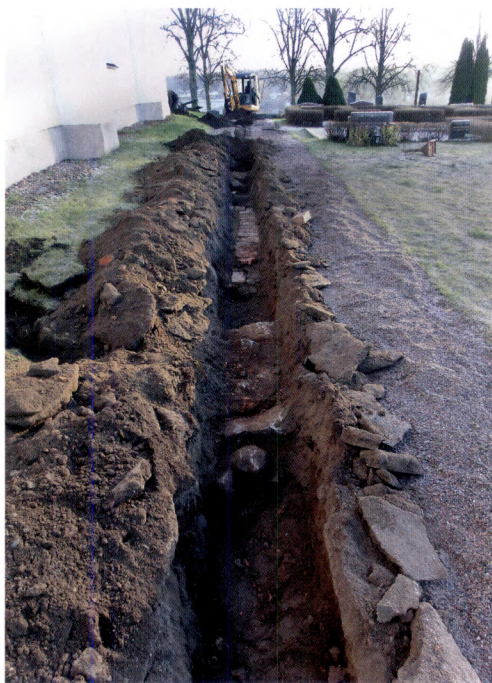
Fig. 3. Smalt schakt för ringledare på södra sidan av Lena kyrka. I schaktet påträffades murarna till det nu rivna vapenhuset och inne i vapenhuset en gravkammare av murad tegel. Foto Bent Syse, Upplandsmuseet.
