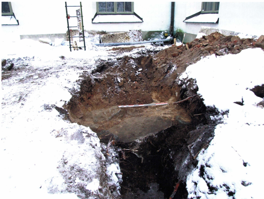
Figur 3. Under vintern 2009–2010 grävdes ledningsschakt runt Alunda kyrka. I samband med detta dokumenterades bland annat den västra muren efter det tidigare norra vapenhuset. Foto Linda Qviström.
