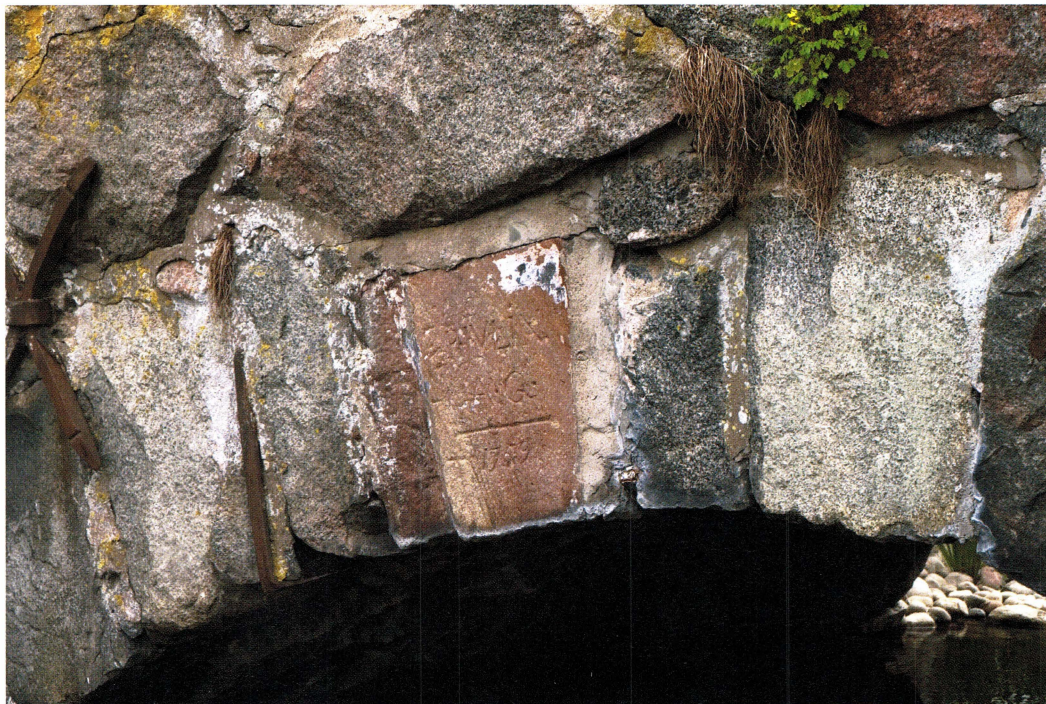
Julins minnessten på norra sidan av koarnbron. Den ursprungliga kallmurade bron har senare fogats med cementbruk. Foto Bengt Backlund.
