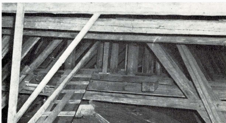
Bild 34 a, b. Från Tegelsmora kyrkas valvwind med rester av den en gång här stående takryttaren. Av basstrukturen framgår att basprofilen varit sexkantig och att den haft sådant läge att sexkantens spetsar utgått vinkelrätt från takkammen. Uppmätning och foto av Lars Gezelius, 1966.
