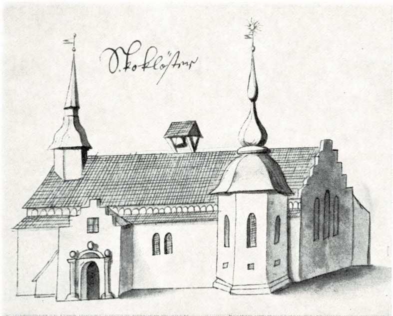
Bild 50. Cisterciensnunnekyrkan i Sko. Hadorph, 1682. Märk den helt mot väster dragna takryttaren samt klockbocken över kyrkans mittparti.
