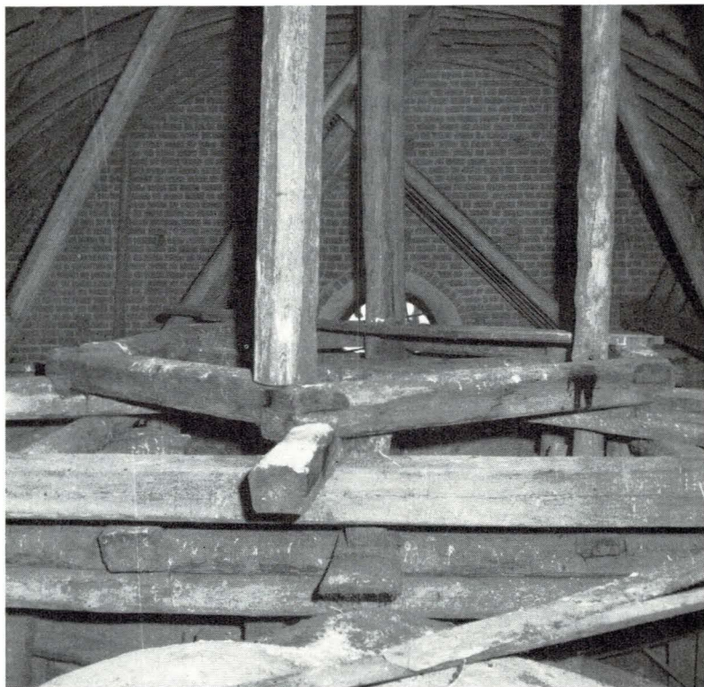
Bild 37. Tensta kyrka, dess valvind med resterna av de forna takryttarna sedda från öster. Bortre väggen kyrkans västvägg. Foto Lars Gezelius, 1966.
