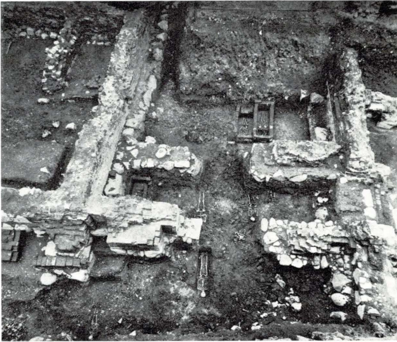
Bild 45. Franciskankyrkan i Uppsala, dess ruin med blick mot öster ner över munkkorets västparti. Hitre tvärmuren triumfbågen med dess två altare. Bortre tvärmuren har stadgat västligaste kortravén, som kunnat hotas av sättningar genom en från dess valv uppbyggd takryttare. Jämför bild 46. Foto E. Skirgård, 1962.
