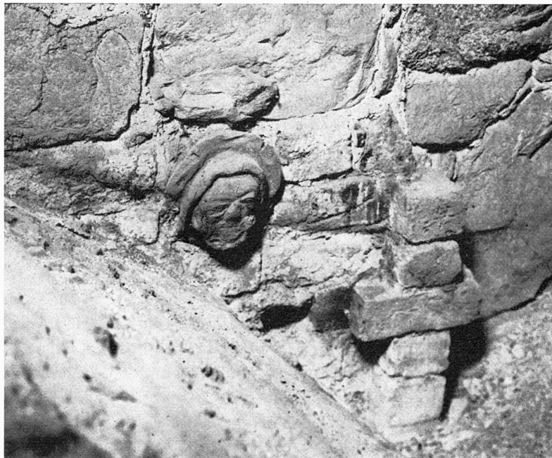
Bild 4. Östra fialens överdel och den intill befintliga ansiktsmasken, sedda från vapenhusvinden. Foto 1959.
