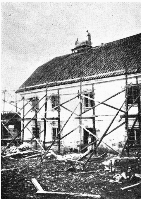
Bild 1. Grenome sätes- byggnad restaureras.
