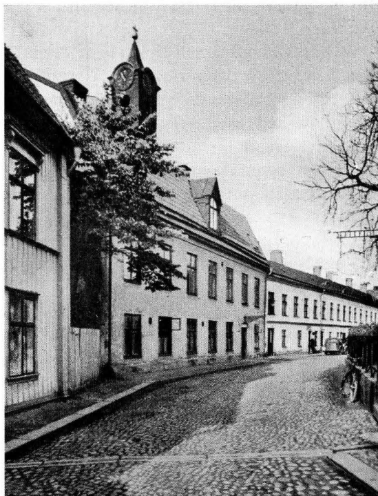
Bild 4. Rådhuset och Rådhusgatan, Enköping.
