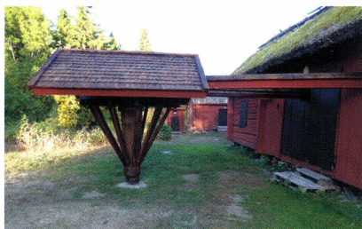
Tröskvandringen på hembygdsgården i renoverat skick.
