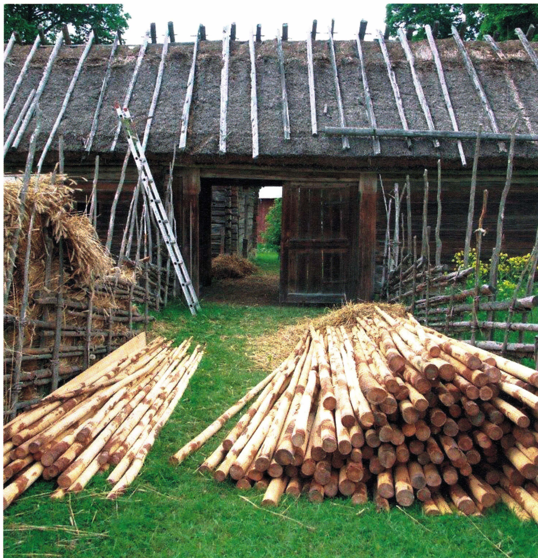
Upplands fornminnesförening och hembygdsförbund äger och vårdar byggnadsminnet Kvekgården i Fröslunda socken, Enköpings kommun. Byggnadsvårdsåtgärder, i form av underhåll av halmtak på mangårdsbyggnad och bodlänga, genomfördes 2012 med bidrag från Länsstyrelsen. Foto Agnetha Pettersson, Upplandsmuseet.
