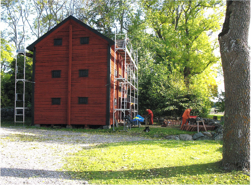
Från arbetet med takrenoveringen på sockenmagasinet. Takteglet skrubbas rent från lava och smuts.
