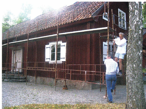
Renovering av taket på hembygdsgården inom ramen för projektet Hus med historia.
