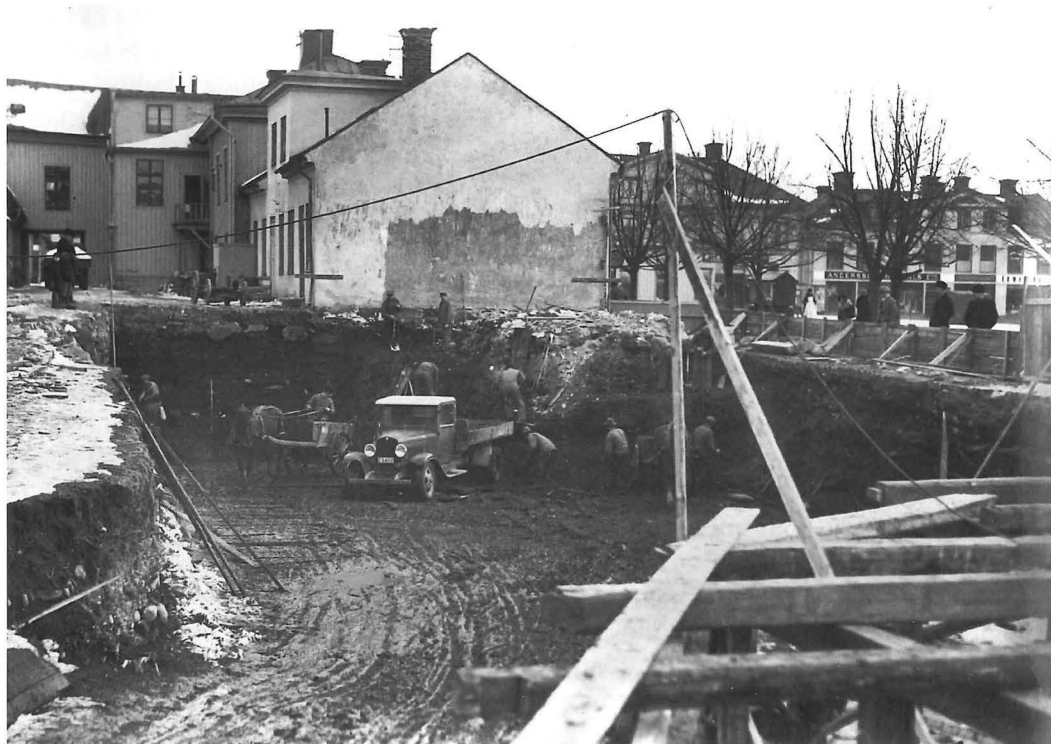
Figur 4. Byggnadsarbeten i kvarteret Borgmästaren i början av 1934. I bakgrunden skimtar Stora torget. I samband med arbetet gjorde Nils Sundquist några arkeologiska iakttagelser av bl.a. husgrunder, stenläggningar, en brunn, rustbäddar och risgärdesgårdar. Foto sannolikt Nils Sundquist, Upplandsmuseet.
