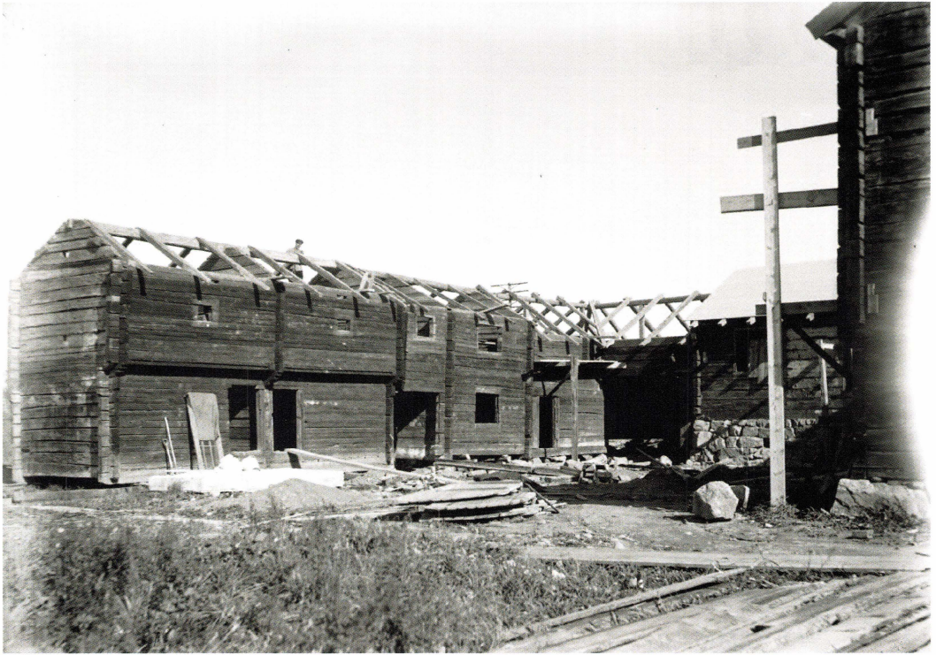
Mangårdslängorna från Gränby nr 2 under uppförande på Disagården. PS09126.
