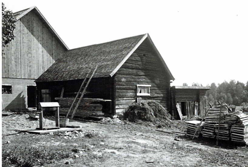
Ladugården och svinhuset på Lilla Bultebo innan flytten till Disagården. PS06462.
