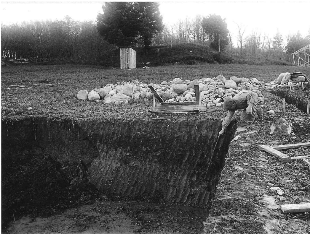
Grundläggningsarbeten för Disagården. PS06820.
