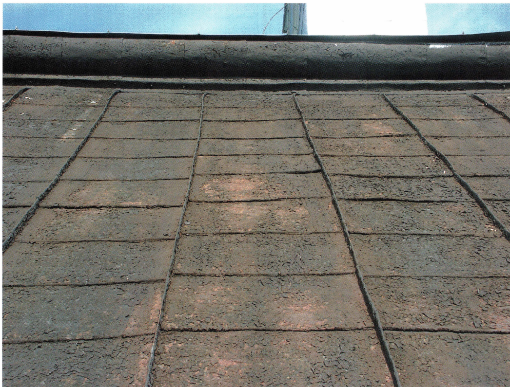
Närbild på den gamla plåttäckningen från 1700-talet. Här ses hur den Hagmaniten bildat en tjock skorpliknande yta. Plåtskivorna är ca 60x45 cm stora och har liggande hakfalsar i en tämligen rak linje parallell med takfoten. DIG002287.
