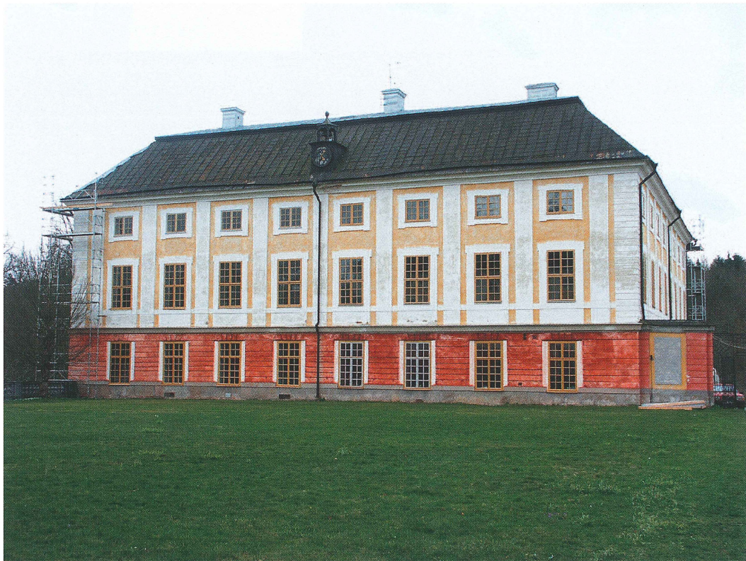
Bilden visar slottet våren 2007 och dess norra sida där renoveringen ännu ej påbörjats. Ställningar är resta på västra gaveln. Det övre flacka takfallet samt skorstenarna täcktes med ny plåt redan 1991. Det nedre takfallet har kvar plåten från 1700-talet. DIG002265.
