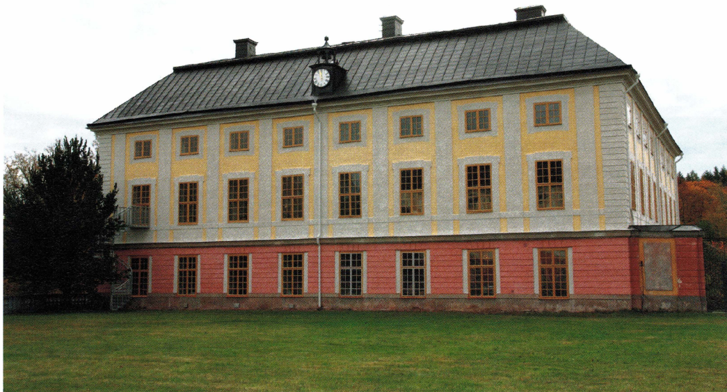
Slottets norra sida efter avslutad renovering hösten 2007. DIG002317.
