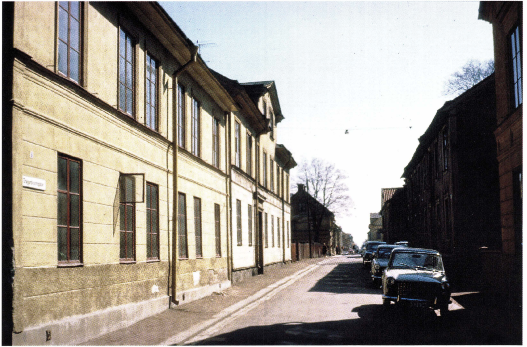
Dragarbrunnsgatan och kv Töven den 1 maj 1963. Foto Ola Ehn (DIA00219) Byggnaderna till vänster hade markerats som värdefulla i Stadsbildens framtid och föreslagits som kulturresevat redan 1956. I slutet av 70-talet var de akut rioningshotade. I skugga till höger ses den gamla brandstationen.
