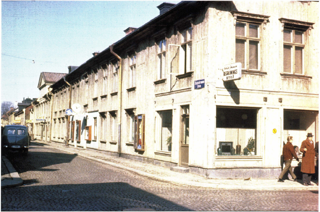
Kvarteret Svanen i mars 1960, foto från hörnet av S:t Persgatan och Dragarbrunnsgatan. Ett par år senare var husen rivna. Det yttre förfallet kan nästan kännas i bilden. Fasadpanel och fönster är i starkt behov av ommålning. DIG00230
