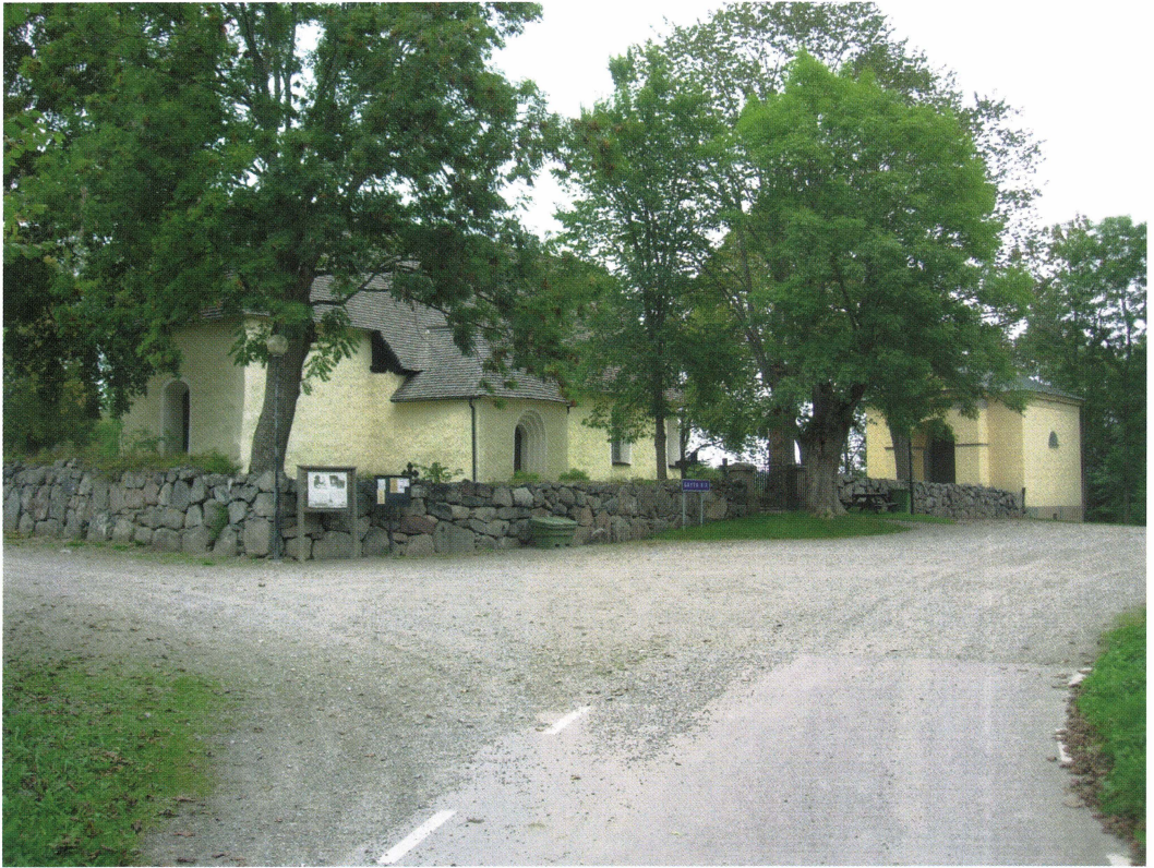
Gryta kyrka med det Spenska gravkoret sett från den förbipasserande gamla landsvägen "Erikskatan". Som synes har gravkoret en mycket framträdande placering, och är det första man lägger märke till då man nalkas kyrkan. Foto Göran Ulväng.
