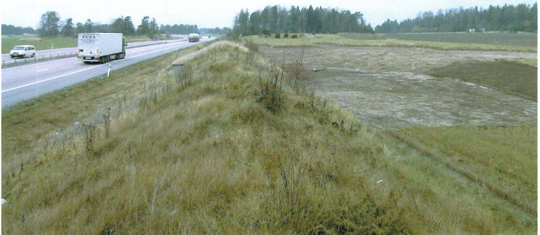
Figur 1. Undersökningsytan av Raä 153 låg intill E4. Foto: Linda Qviström.
