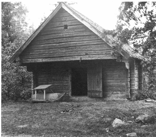
Knuttimrad bastu med kraftigt utskjutande loftparti på gaveln. Taket är täckt med stickspån. Knutskallarna på långväggen markerar innerväggen mellan bastun och förstugan eller bastufarstun. Ragvaldsbo, Vendels socken. Foto: Nils Ålenius. Nordiska museets arkiv.
