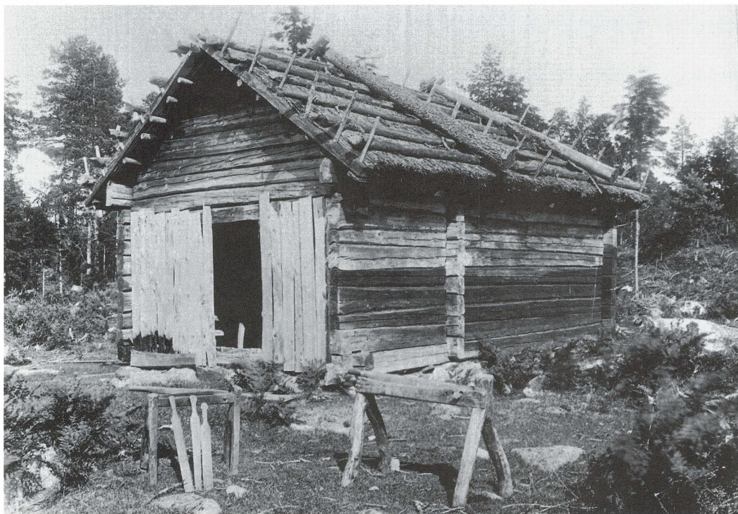
Knuttimrad bastu med vasstak. Hällens by, Hällnäs socken. Foto: Nils Ålenius. Upplandsmuseets bildarkiv.
