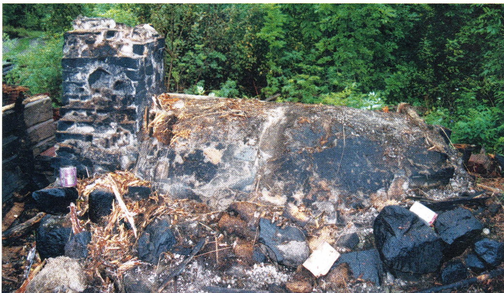
Ugnen i knuttinrad bastu från Inninge, Stavby socken, dokumenterad i samband med flyttning till friluftsmuseet Disagården. Se bastun sid. 57. Den murade ugnen är placerad i bastuns ena hörn, mot svalen. Foto: Karin Mannberg Wretin.
