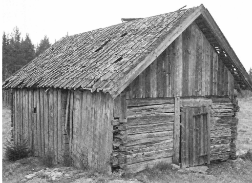
T.v. knuttimrad bastu, delvis klädd med stående bräder, tegeltak. Svandal, Annö, Valö socken. Foto: Birgitta Svensson. T.h. knuttimrad bastu med halmtak och delvis inbyggd svale. Barknåre, Hållnäs socken. Foto: J-E Tomtlund. Upplandsmuseets arkiv.
