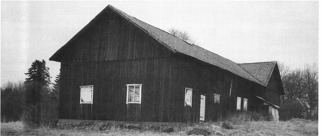
Den numera rivna ladugårdslängan som tillhört den Grandinska fastigheten i Storvreta, belyser ett stycke historia som intresserat Kultur- och Hembygdsföreningen. Foto: Holger Fröjmark.
