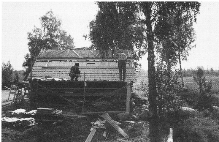
Magnus och Ivar lägger spåntak på den gamla sjöboden.
