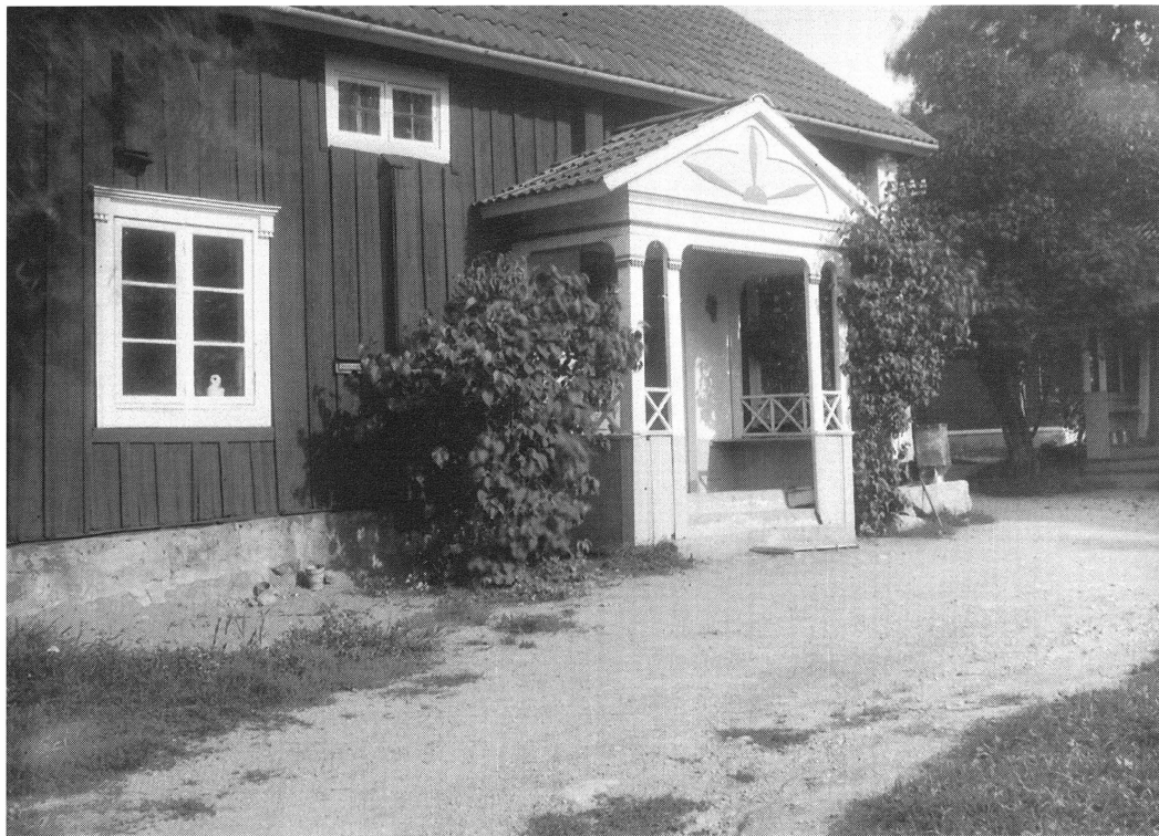
Mangårdsbyggnad med vacker förstukvist i empirestil, Sävasta, Altuna socken. Odaterad.
