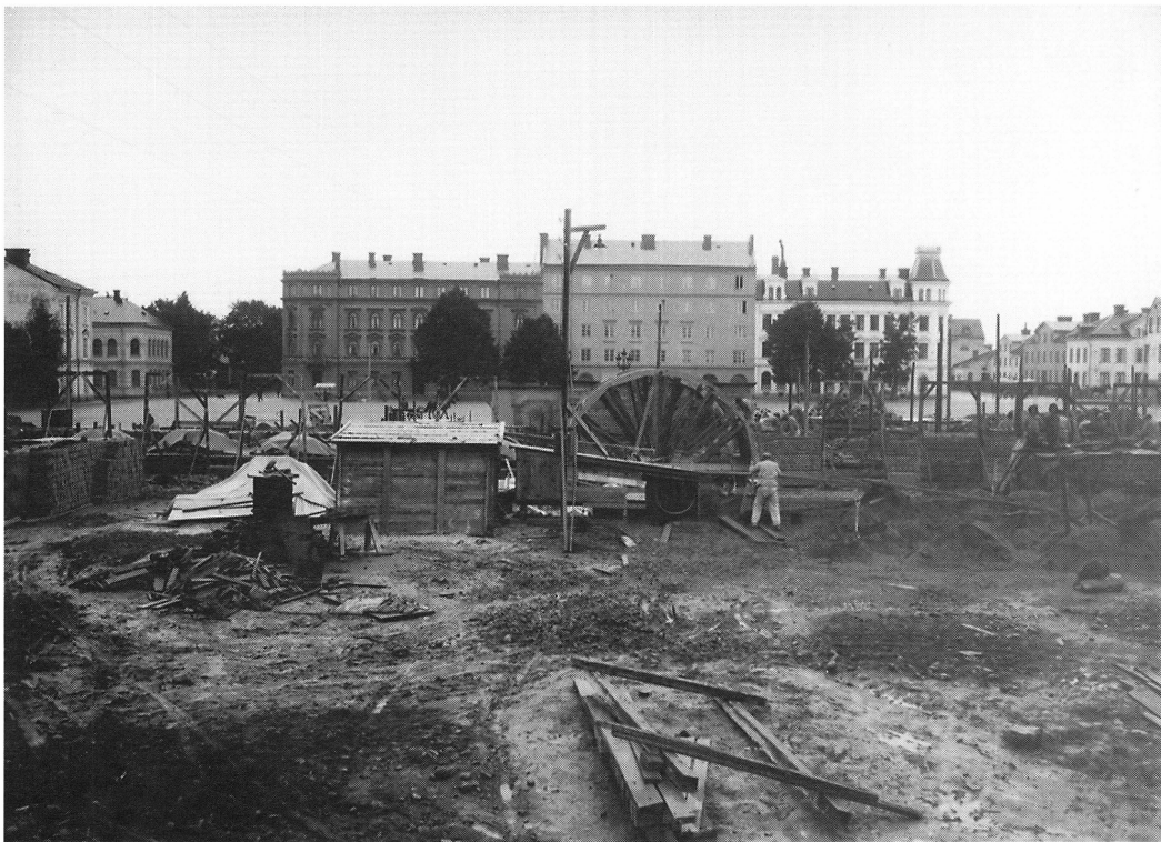
Vaksala torg, Uppsala 1925. Uppförandet av Vaksalaskolan är påbörjat.
