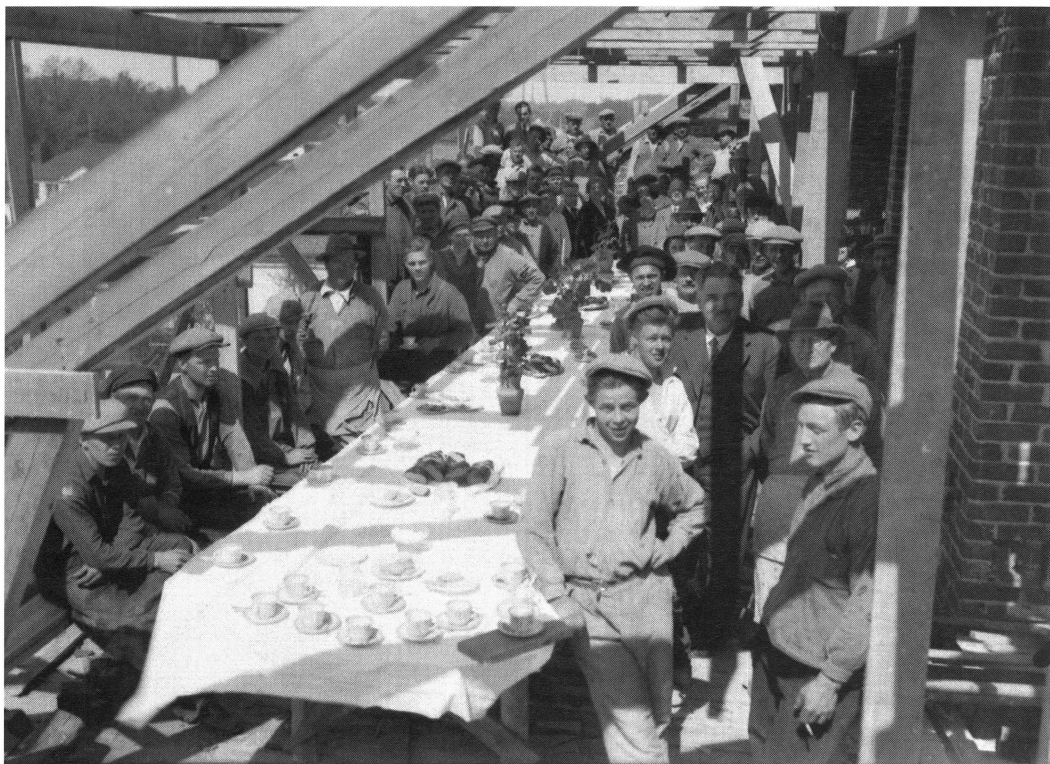
Taklagskaffe på oidentifierad byggarbetsplats i Uppsala.
