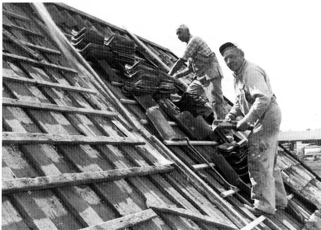
Fastighetskommitténs ordförande Gösta Berlin och snickare Ivar Olsson reparerar taket på tiondeboden vid museet sommaren 1992. Foto Gunnar Lager.
