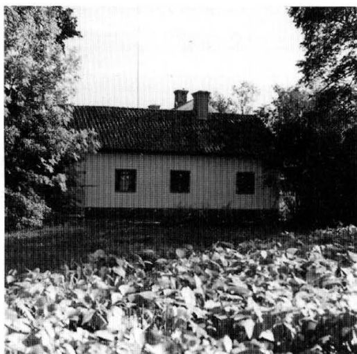
Gamla manbyggnaden från väster, den enda byggnaden på prästgårdstomten som är reparerad och putsad. Foto Karin Mannberg Wretin.
