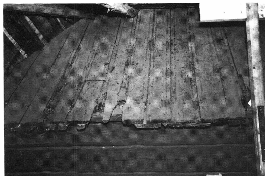
Under taket till den på magasinssflygeln tillbyggda vedboden syns magasinets nedre takfall med ursprungligt brädtak. Foto från 1959 i Nordiska museets arkiv.
