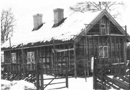
Parstugan från Rotsunda under uppförande mars 1988. Foto C. Rindström.
