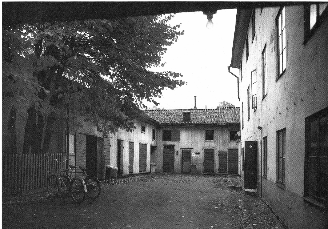
Gårdsinteriör, Kungsängsgatan 24, kv Hästen. Foto Upplandsmuseet 1954.
