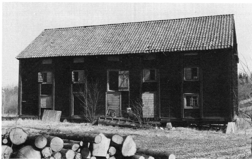
Bruksmagasinet i Länna bruk i Almunge socken har dokumenterats inför eventuell rivning. Foto: Lars Gezelius.
