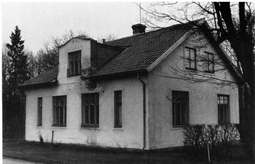
Inför rivning har det i jugendstil byggda brukskontoret i Harnäs bruk, Älvkarleby socken, dokumenterats. Foto: Lars Gezelius.
