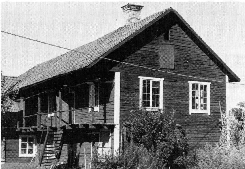
Den nyare delen av garveriet med den karakteristiska altanen utmed långidan. Bakom de stora fönstren på gaveln ligger verkstaden och under denna saluboden. Foto: Karin Blent 1984.
