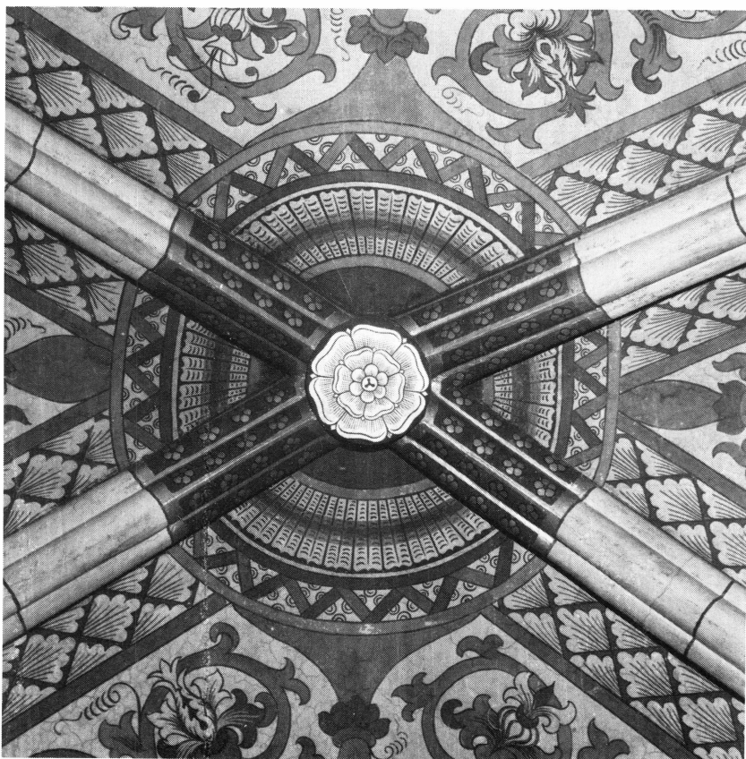
”Problemvalvet” i södra transeptet. Kryssribba typ 3 och slät slutstensbricka med målad ros. Foto: L. Gezelius.
