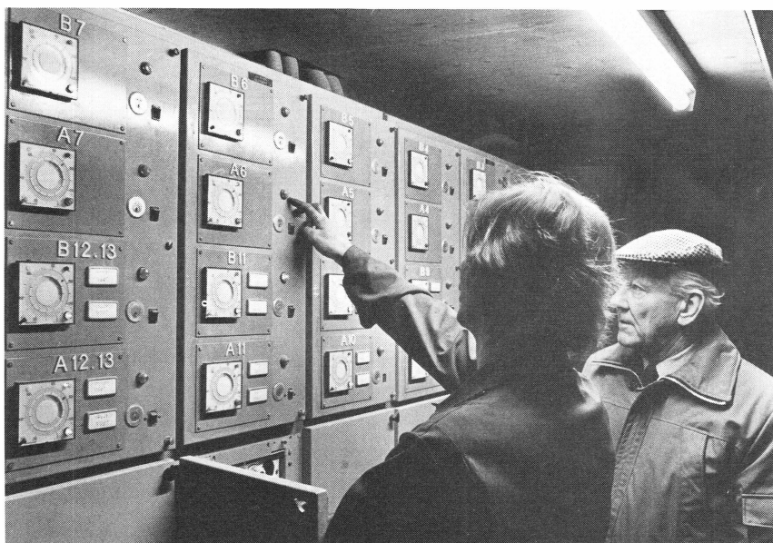
Bild 19. Pauli Iiskola och platschef Ivar Lind diskuterar ett fel i instrumentet för en av ugnens brännare.
