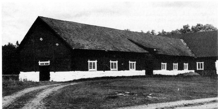
Bild 11. I det stora ladugårdskomplexet ingår stallet som sannolikt är uppfört under 1800-talets förra hälft. Väggar utgörs upp till fönstren av gråstensmurar.
