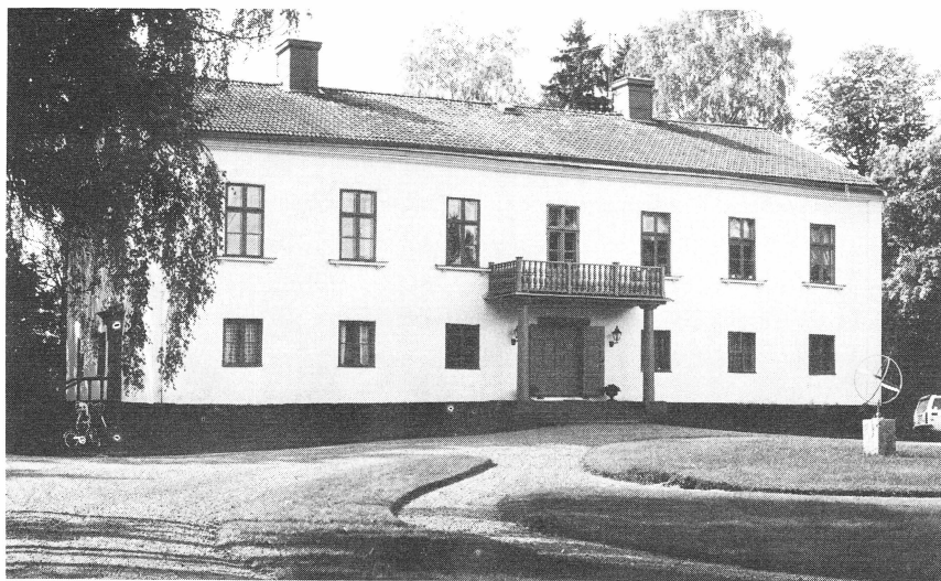
Bild 1. Huvudbyggnaden på Österby har i allt väsentligt behållit sitt ursprungliga utseende från början av 1800-talet.
