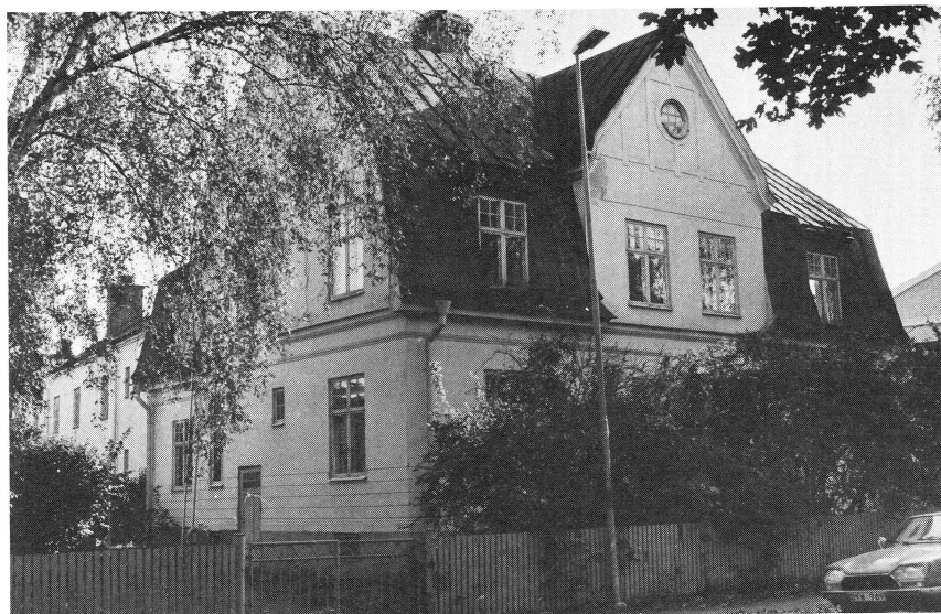
Kvarteret Bjarne i Uppsala, huset i hörnet mellan Norrlands- och Jumbilsgatorna. Foto inför planerad rivning. Foto Lars Gezelius.
