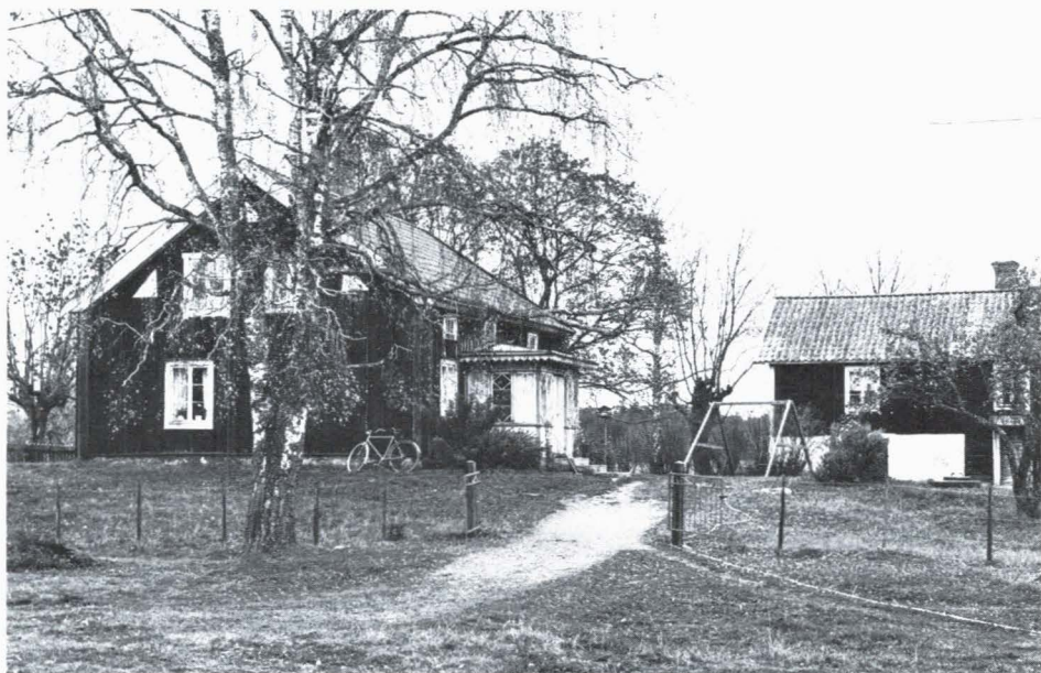
Bostadshus och brygghus från 1800-talets andra hälft vid gården Skaten inom Söderboda by, Gräsö socken. Gårdens bebyggelse bildar en av de välbevarade gårdarna i byn, vilken i den kulturhistoriska inventeringen av Gräsö bedömts ha mycket stort bevarandointresse. Foto Karin Löfgren.
