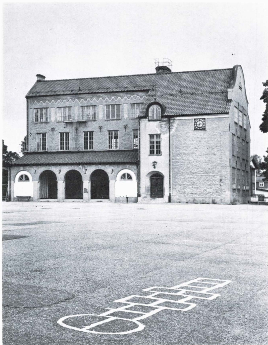
Bild 20. Annexbyggnad till Sverkerskolan, uppförd enligt ritningar från 1922 av Gunnar Leche. Foto T. Arwidson, Upplandsmuseet.
