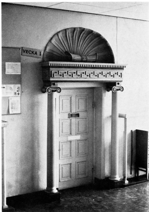
Bild 22. Vaksalaskolan. Invändig dörr med om- fattning. Foto I. Seeger 1981.
