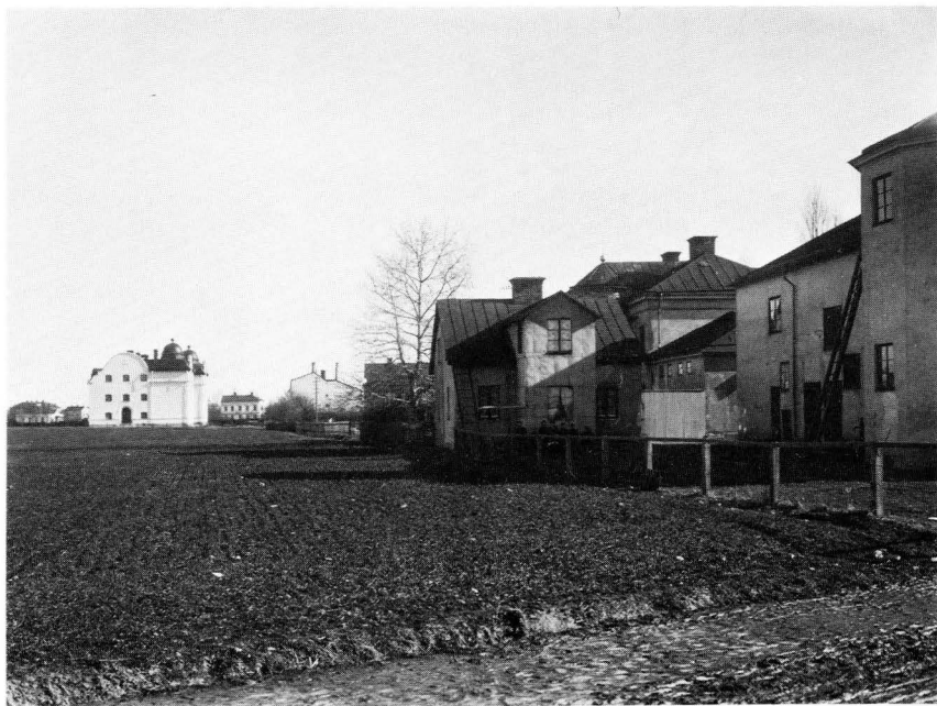
Bild 13. Sverkerskolan från väster strax efter invigningen. Byggnaden uppfördes på åkermark utanför den dåvarande Luthagsbebyggelsen. Foto A. Dahlgren 1908. Upplandsmuseet.
