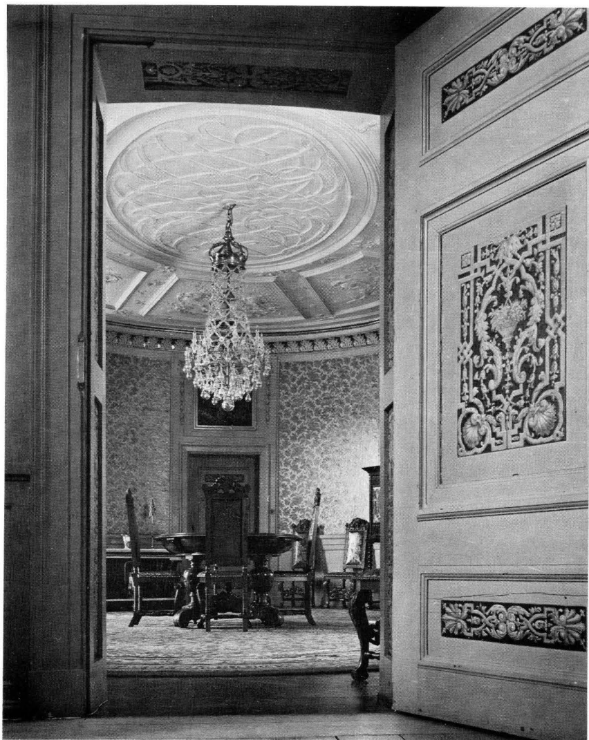
Bild 20. Blick in mot den ovala matsalen i bottenvåningen. Märk dörren med den ursprungliga dekoren. Salens taklist ursprunglig men plafonden med G. B. A. Holms spegelmonogram uppsatt vid restaureringen 1907. Foto Iwar Anderson.
