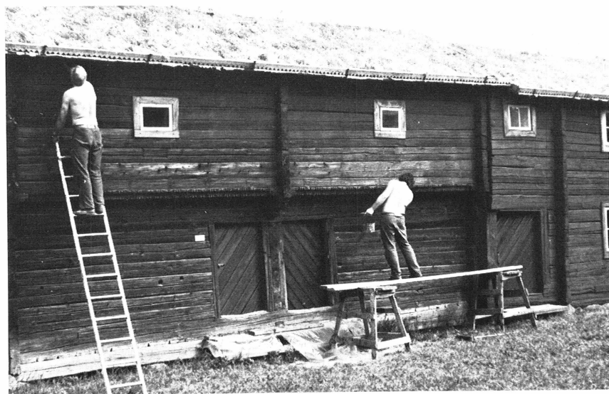
Byggnaderna på Disagården kräver kontinuerligt underhåll. Här rödfärgas en mat- och spannmålsbod från 1700-talets början inom den s. k. Gränbygården från Björklinge socken. Foto E. Claesson.
