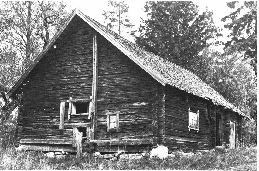
En äldre timrad ekonomilänga vid Kvarnberg intill Fiby urskog i Vänge socken som har rivits under året. Möjligen härrörde denna byggnad från den tid då Vänge-Gustavsbergs stenkärlsfabrik var i drift på platsen. Foto L. Gezelius.
