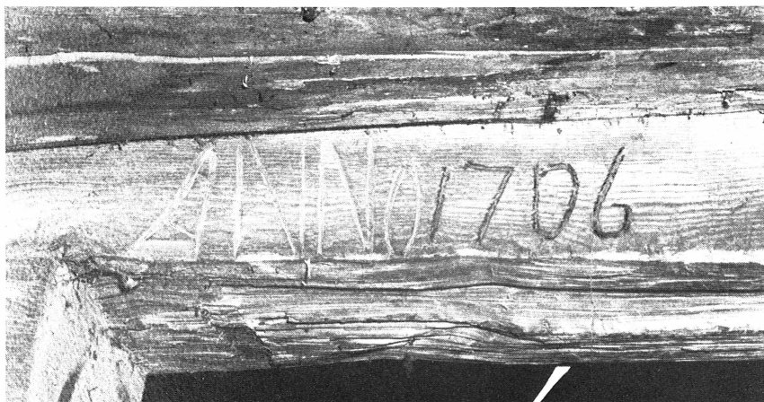
En del av stommen i bottenvåningen till en panelklädd bod inom gården S:t Johannesgatan 23 i kvarteret Hörnet i Uppsala bestod av en äldre rödfärgad timmerbod med året 1706 inristat över dörren. Foto L. Gezelius.
