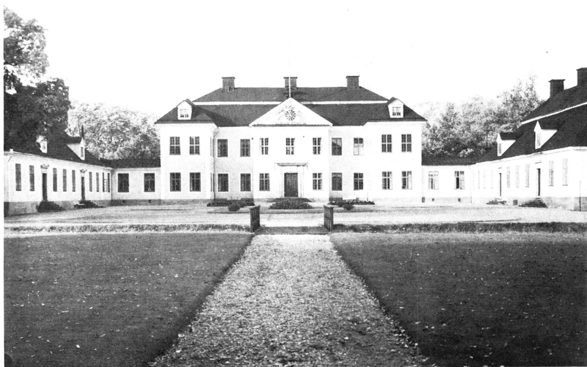
Bild 9. Huvudbyggnaden och flyglarna med de på 1800-talet byggda låga förbindelserna. Foto Selling NM 1935.
