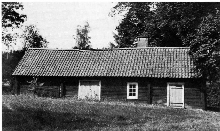
Inför ombyggnad till restauranglokal dokumenterades den till det yttre välbevarade brygghuslängan från 1700-talet vid Vårdsättra gård i Bondkyrko sn. Foto Lars Gezelius.
