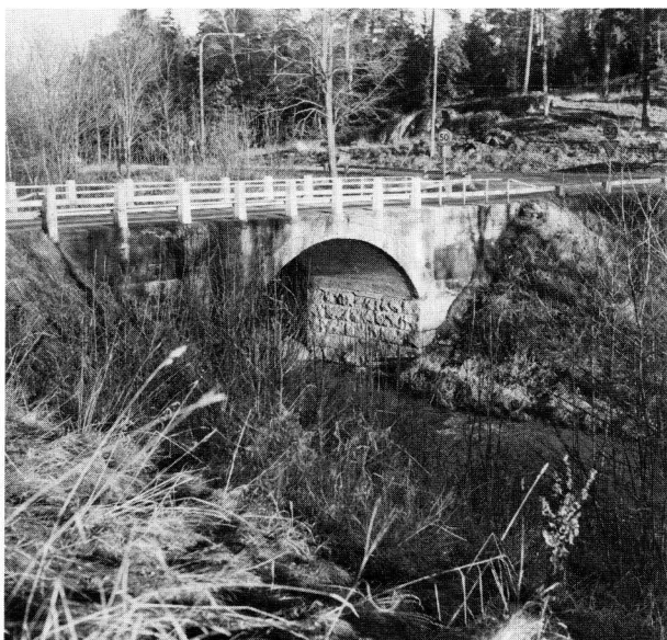
Landsvägsbron över Hågaån vid Lurbo i Bondkyrko sn. Dokumenterad inför rivning. Foto Lars Gezelius.
