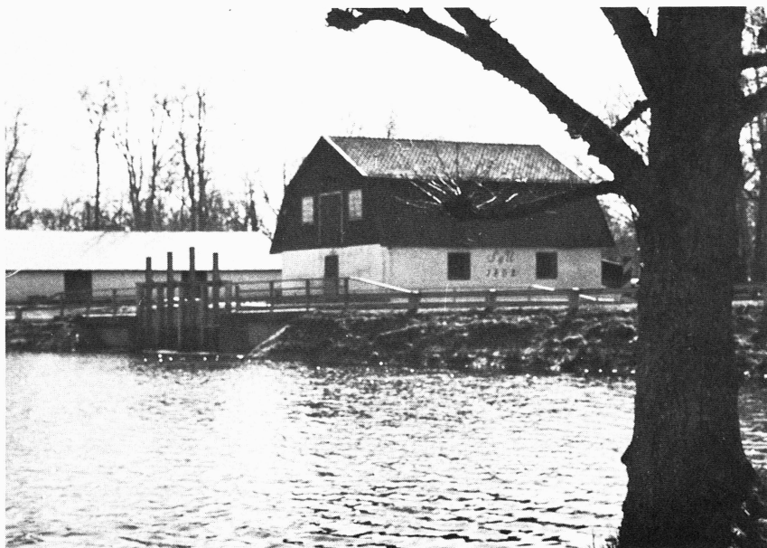
Bild 9. Kvarnslutaren vid Verkstadsdammen i Forsmark. Vägbanken för länsväg 76 utgör här dammsbröst. Foto förf.
