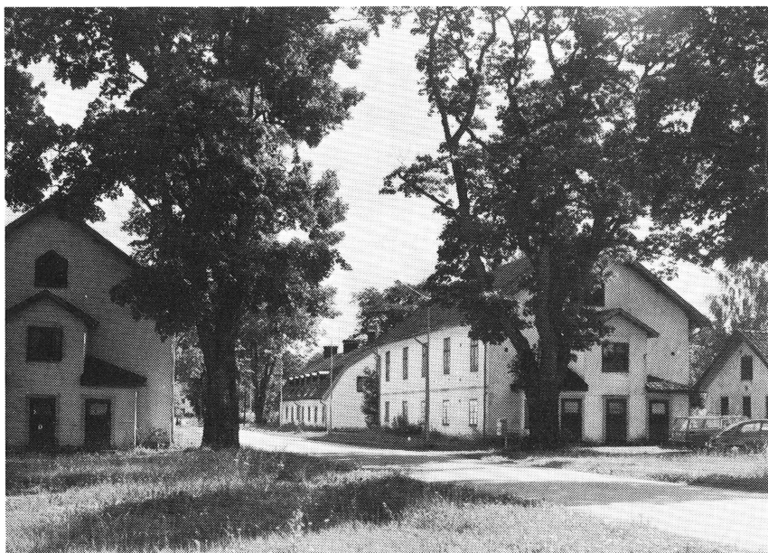
Stenusgatan i Gimo bruk med arbetarebostäder uppförda på 1760-talet enligt ritningar sannolikt av Jean Eric Rehn och påbyggda omkr. 1880. Här påbörjades 1977 en genomgripande sanering, inför vilken en dokumentation genom uppmätning och fotografering utfördes. Foto Lars Gezelius.
