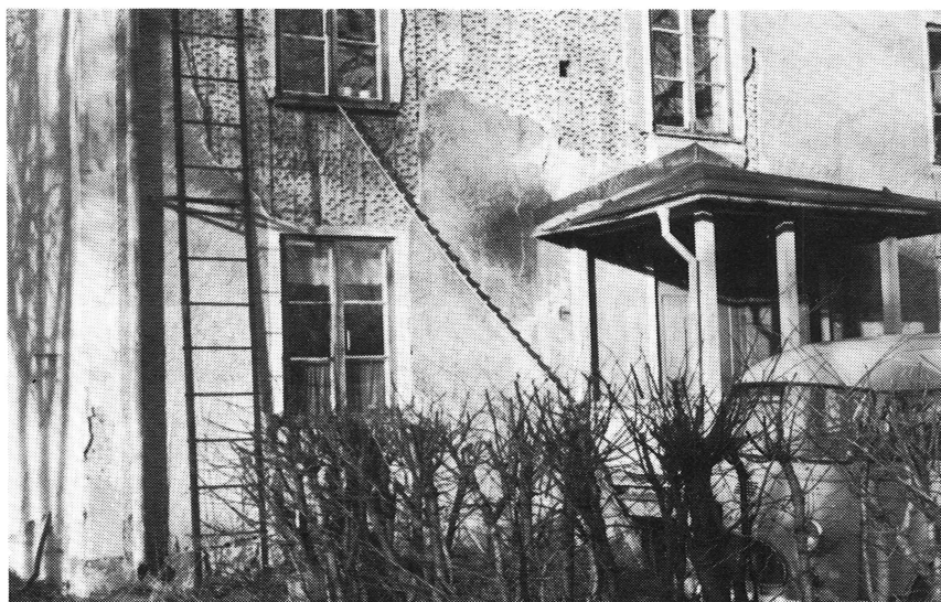
Bild 10. Gårdsbild från kvarteret Stammen (Luthagen 52:5). Lägg märke till kattstegen upp till fönstret på andra våningen och byggnadsstommen med det stående timret. Huset byggdes på 1880-talet och innehöll små hyreslägenheter. Foto förf. 1977.
