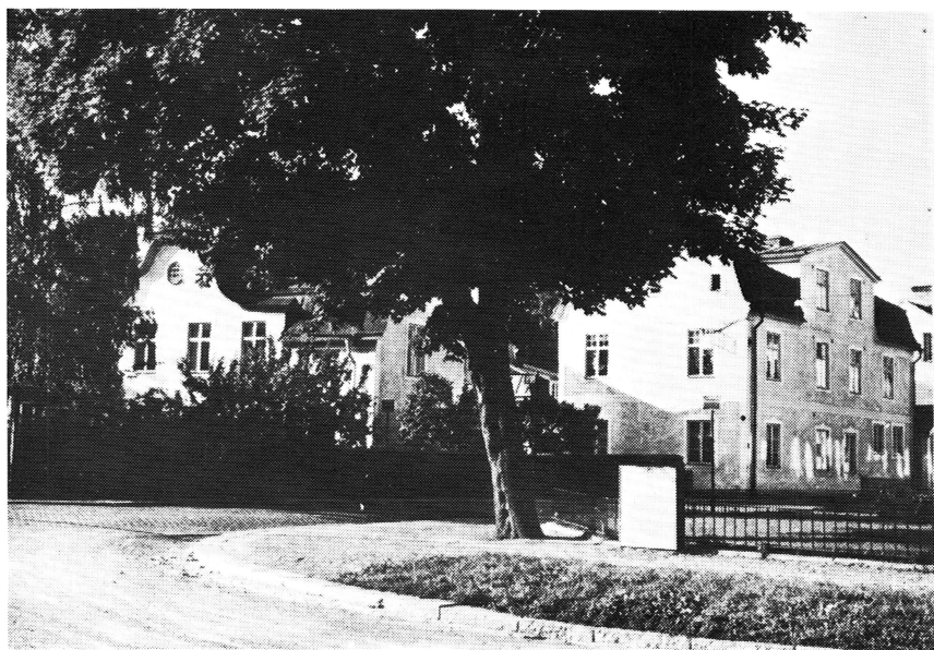
Bild 3. Kvarteret Stammen (Luthagen 52:3), hörnet Sibyllegatan-Geijersgatan. De båda husen byggdes på med en våning omkr. 1905. Foto omkr. 1950.
