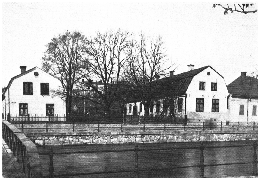
Bild 52. Västgöta nation inköpte 1825 fastigheten nr 6 och 7 i kvarteret Kaniken, en f. d. professorsgård i hörnet av Slottsgränd och Västra Ågatan. Huvudbyggnaden, uppförd av sten 1666 på en medeltida källare, hade blivit ombyggd i slutet av 1700-talet ungefär samtidigt som ett bostadshus av trä upplfördes längs Slottsgränd. Till en början utnyttjade nationen endast ett rum i huvudbyggnaden. Resten hyrdes ut. Foto 1800-talets slut. UFF.
