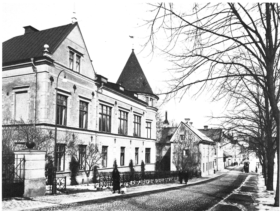
Bild 51. Södermanlands-Nerikes nationshus i kvarteret Rosenberg blev det femte nationshuset vid S:t Larsgatan. Det uppfördes enligt ritningar från 1896 av uppsalaarkitekten Gerdt Hallberg. Fastigheten var en gammal professorsgård, vars huvudbyggnad från 1811 i hörnet av S:t Larsgatan och S:t Olofsgatan fick ligga kvar. Foto 1920-talet. UFF.
