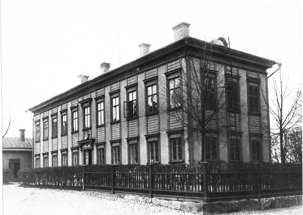
Bild 22. Västmanlands-Dala nationshus från öster med ytterpanel från 1842. Panelen stod från början vitmålad, medan allt listverk var målat i grått. Jämför bild 23. Foto A. Dahlgren 1902. UFF.
