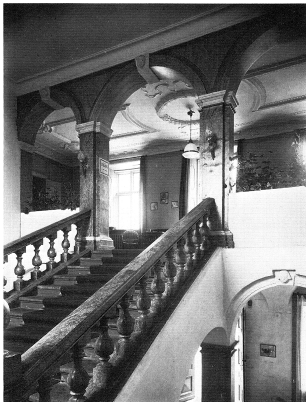
Bild 7. Trapphuset på Haga efter I. G. Claessons ombyggnad 1913. Observera att de ursprungliga balustraderna av marmorerat trä befinner sig på ursprunglig plats, men att själva trapporna bytt plats. Foto omkr. 1930 under herrgårdens pensionatstid. Nordiska museet.
