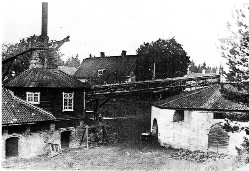
Bild 1. Rostugnen och masugnen i Bennebol. Banan som förde den rostade malmen från rostugnen upp till masugnen finns i dag inte kvar. I bakgrunden inspektorsbostället. Foto omkr. 1910.
