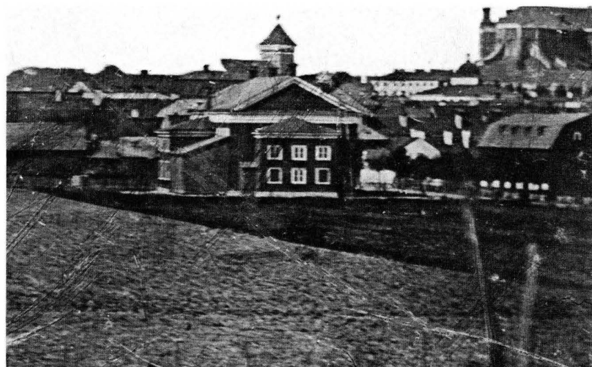
Bild 6. Detalj av daguerreotypin på bild 5 med till vänster teaterbyggnaden från 1842, i mitten Vaksala tullstuga från 1762 och till höger Schagerströms vagnslider och sädesmagasin från 1839, sedermera Vålamagasinet.
