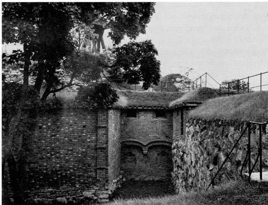
Bild 26. Uppsala slott, åsfästningens norra bastion, Styrbiskop; södra orillonen efter konserveringen. Bevarat murverk visar att bastionen haft två kasemattvåningar, av vilka den nedres kanonfönster helt återstår; under bågarna, vid mitten burna av profilerad konsol av kalksten, mynnar nerslagshålen från övre kasemattvåningens kanonfönsterbänkar. Foto Arne Johansson 29 aug. 1951.
