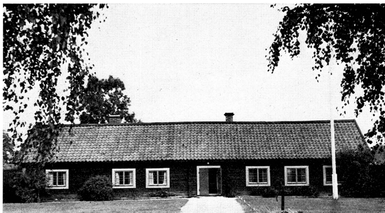
Stockholms-Näs hembygdsförening: Mangårdsbyggnad från 1600-talcts slut med tillbyggd samlingslokal t. h. om ingången. På ursprunglig plats.
