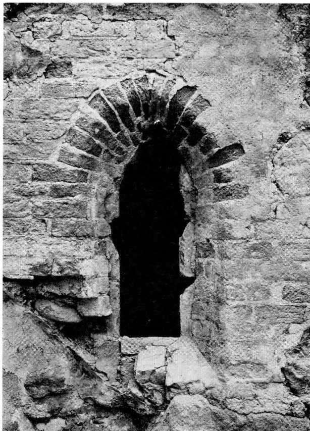
Bild 6. Fönstret i sakristians östvägg. Utsidan. J:son foto.
