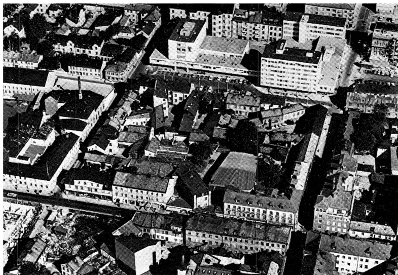
Bild 2. Flygfoto över kv. S:t Per mot norr. Den snett stående byggnaden utmed gatan i bildens nedre del är Observatoriet. I kvarterets övre högra hörn de två öst-västligt orienterade husen på gården Dragarbrunnsgatan 29. Foto Manne Lind.
