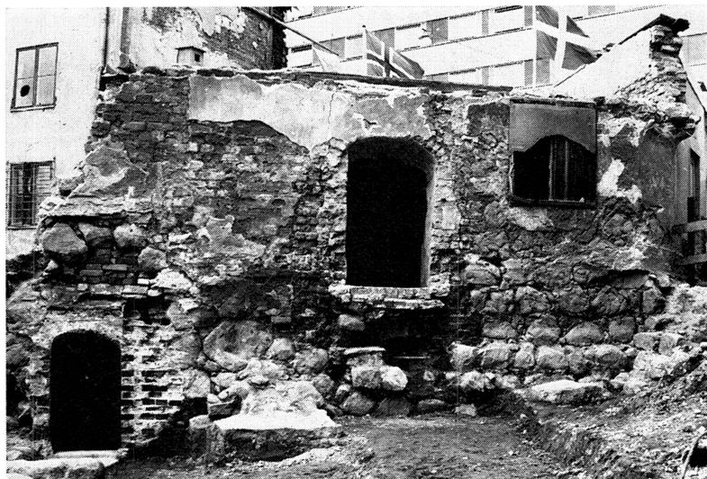
Bild 4. Sakristian fr. söder. Porten t.v. leder till källare under den norra kapellsviten. Öppningen mitt i bilden är den sekundära porten till sakristian, den ursprungliga skyntar under den nuvarande (en tröskelsten under vänstra smygen) och något t.v. Fönstret t.h. är sentida. Foto Evert Skirgård.
