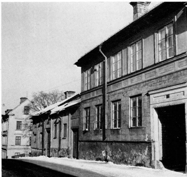
Bild 21. Fastigheterna nr 4, nr 5 och nr 6 i kvarteret S:t Niklas, fasaderna mot Övre Slottsgatan. Foto Karl Johan Eklund 1964. UFF.
