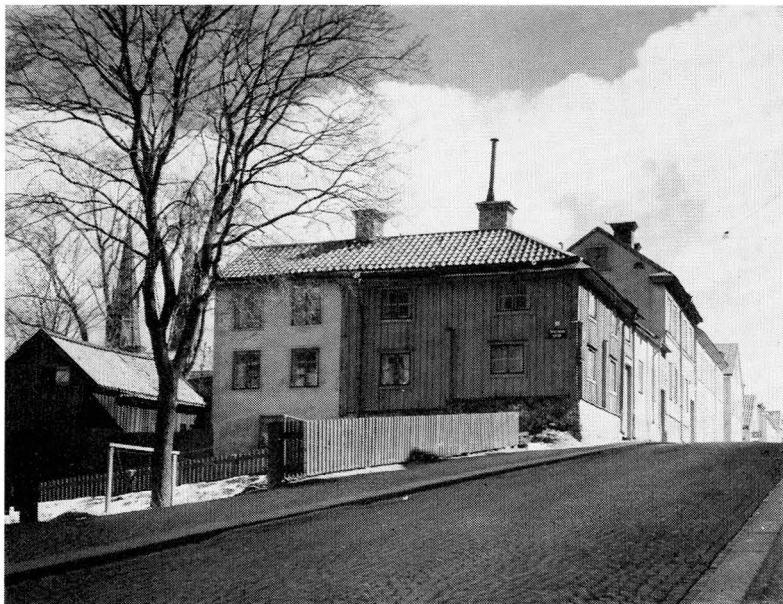
Bild 6. Kvarteret S:t Niklas från nordväst. Vid backkrönet i hörnet av Övre Slottsgatan och Svartmangatan ligger fastigheten nr 4, den s.k. Rackarnäbben, med äldsta delar möjligen från 1600-talet. Foto Anna-Märta Berg 1936. Upplands fornminnesförening (UFF).
