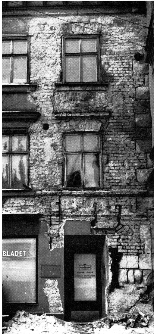
Bild 5. Norra delen av Sigfridssonska husets fasad mot Stora torget sedan putsen bortknackats. Till höger framträder den ursprungliga hörnkedjan och bottenvåningens höga sockel av gråsten. Foto förf. 1963.
