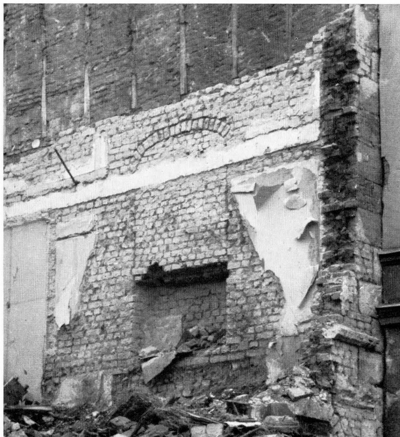
Bild 7. Det Sigfridssonska husets nordvästgavel blottades vid rivningen 1963. På bilden ses ett av de igenmurade ursprungliga fönstren i vån. 1 tr. Foto förf. 1963. Jfr bild 6.
