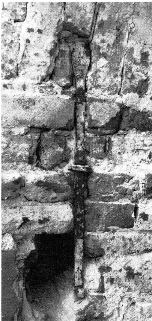
Bild 9. Ankarslut från det Sigfridssonska husets första byggnadstid. Från början fanns sannolikt en volut på vardera sidan och en snurra framtill. Foto förf. 1963.
