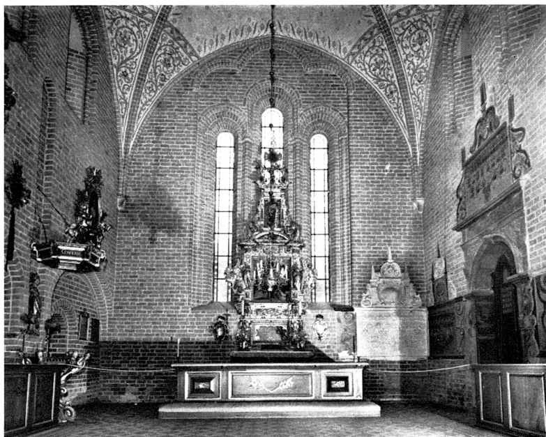
Bild 6. Sko cisterciensnunnekyrka, korväggen, med det sammansatta fönstret, det arkitektoniskt rikaste i Mälardalen. Både fönstrens arkivolter och den förkroppade omfattningens högdelar stiger från kapitäl i natursten. Foto E. SKIRGÅRD 1963.
