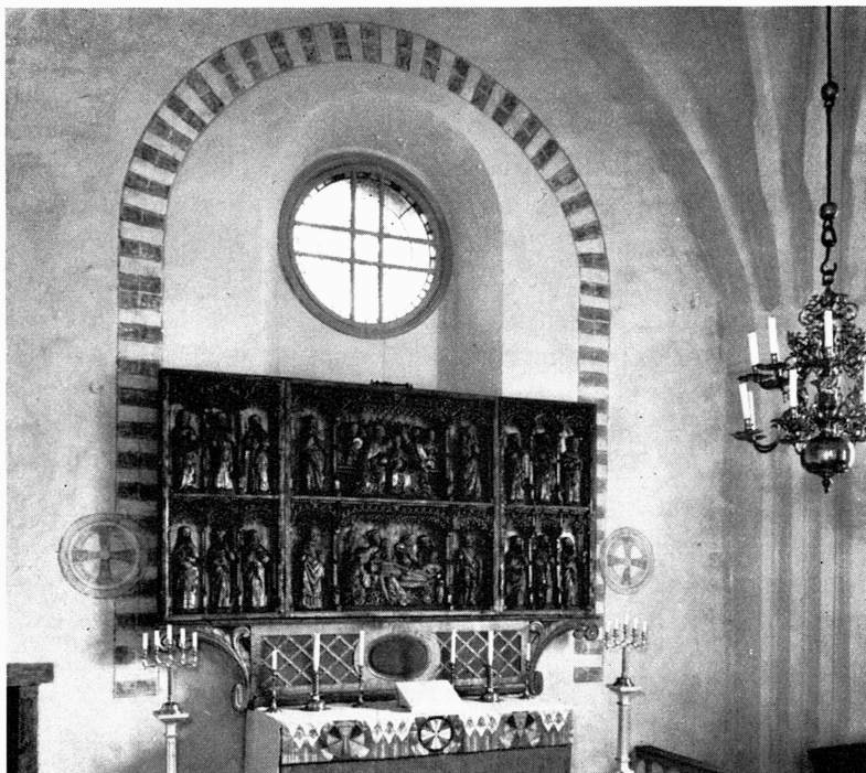
Bild 1. Boglösa kyrka, korväggen efter restaureringen 1959. Bågen med de olikfärgade teglen kan markera den grunda nisch, som under medeltiden omgivit ett sammansatt korfönster. Foto E. SKIRGÅRD 1963.
